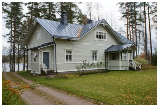
Kuva: Koiraniemi, rakennettu Olkkolan vanhasta päärakennuksesta
