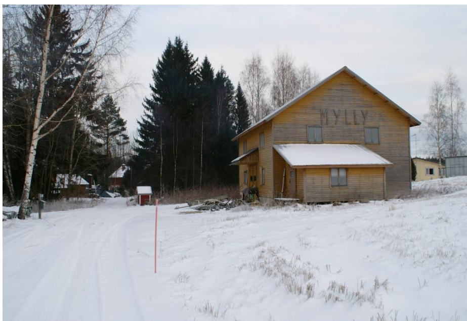
Kuva: Tikan myllyrakennus. Takana oikealla samaan tilaan kuuluva 1980-luvun asuinrakennus. Tien varrella näkyy kuivaamo ja Tikkalan navetta.
