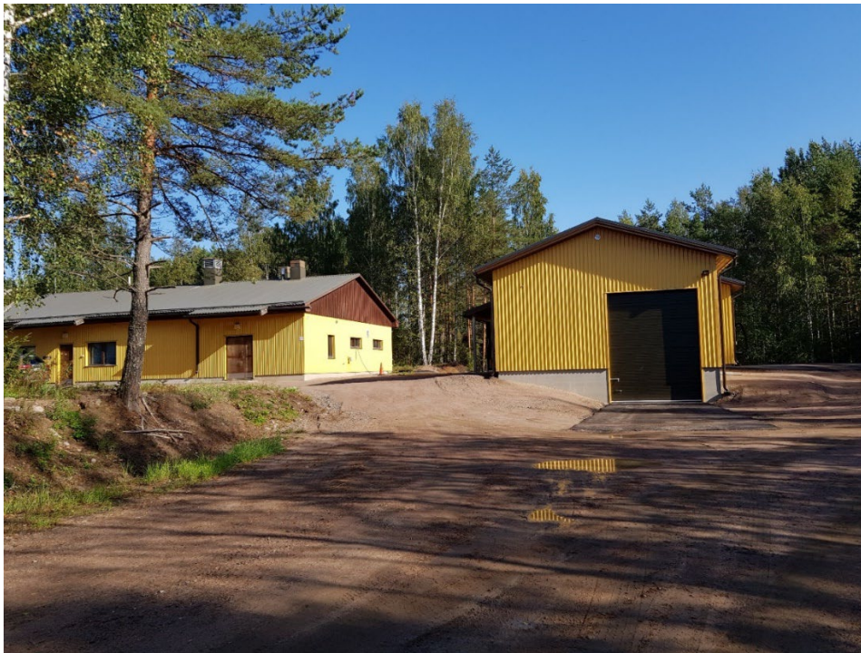
Kuva 2. Savitaipaleen Pöksänlahden vuosina 2017-18 saneerattu jätevedenpuhdistamo
