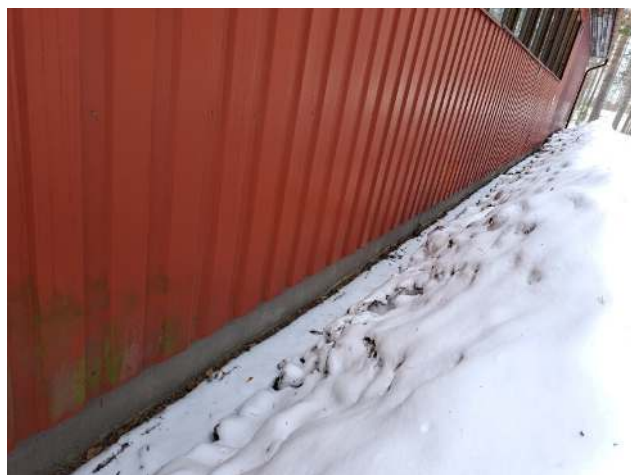
2. Perustukset ja sokkelit:
