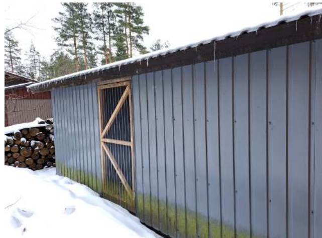
6. Sadevesikouru puuttuu
