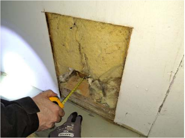
11. Seinän rakenne lämpimissä tiloissa
