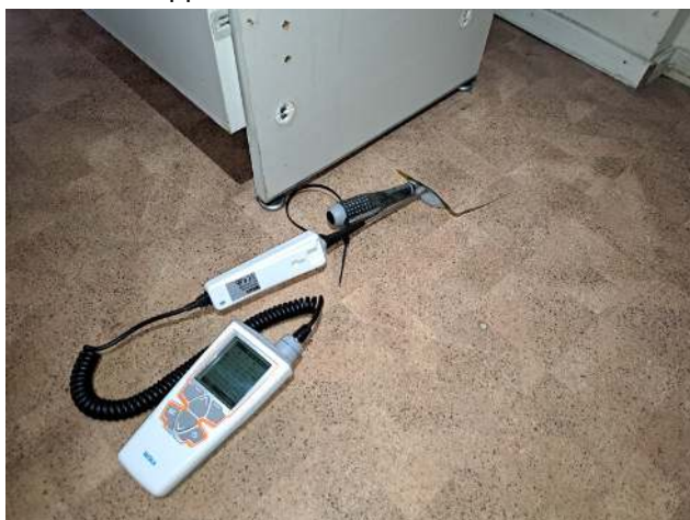
38. Viiltomittaus taukotilan lattiasta
