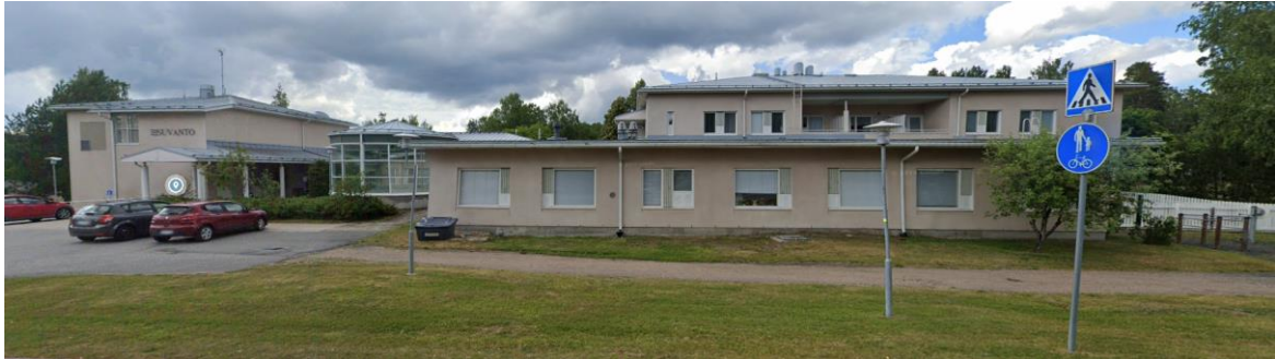
Kuva 7 Asemakaavan mukaisella tontilla nro. 3 sijaitseva rakennus. Rakennuksessa toimii uimahalli ja rakennus käsittää asuinhuoneistoja.
